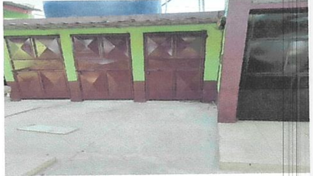
Foto 2: TRABAJO CULMINADO EN REPARACION Y MANTENIMIENTO DE PUERTAS DE BAÑOS
