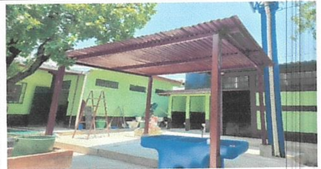
Foto 6: TRABAJO CULMINADO DE COLOCACION DE PILA DE DOS LAVADEROS Y REPARACION DE AREA DE TECHO DE LA PILA
