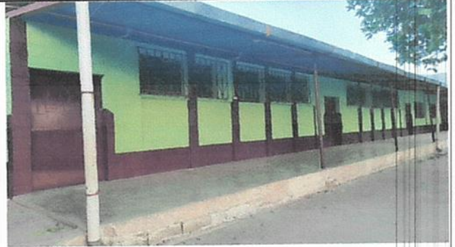
Foto 4: TRABAJO CULMINADO EN PINTURA DE MURO DE INTERIORES Y EXTERIORES TANTO DE PUERTAS COMO DE BALCONES
