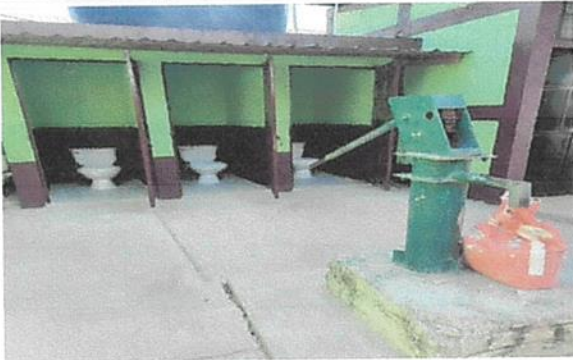
Foto 1: TRABAJO CULMINADO DE COLOCACIÓN DE BAÑOS
