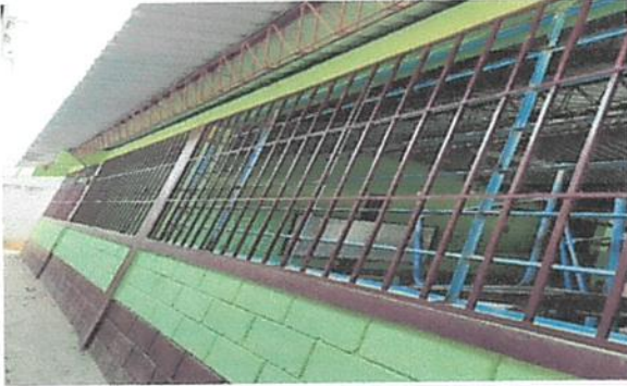
Foto 3: TRABAJO CULMINADO EN SUSTITUCIÓN DE BALCONES EN AULAS
